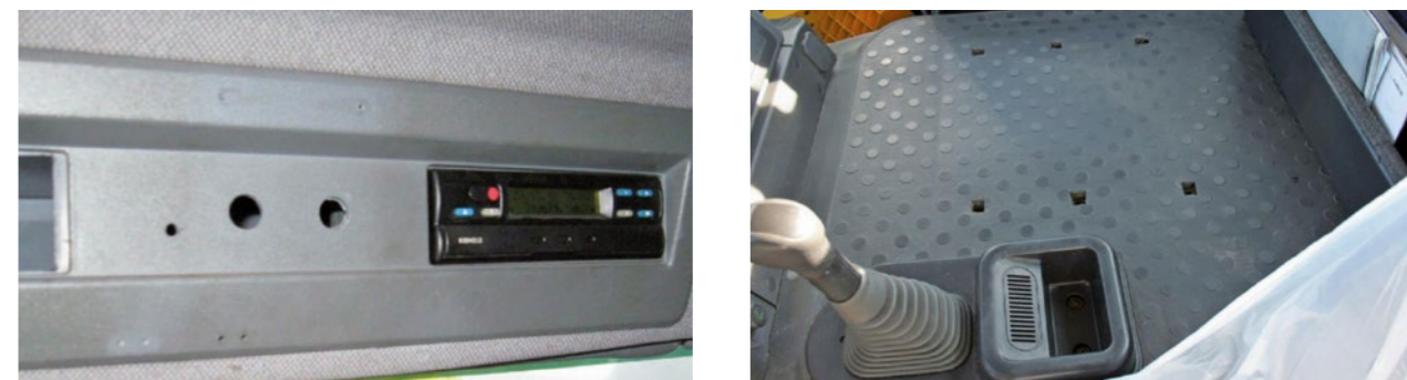
Componenti di comando, componenti del sedile o del rivestimenti mancanti, rotti o forati
