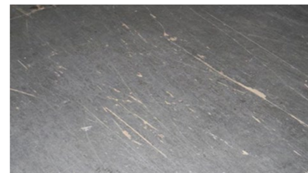
☰ Pavimentazione: leggera deformazione, usura superficiale
