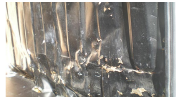
Deformazioni interne: Deformazione rilevante, tempo di riparazione > 3 h, perforazioni, tagli
