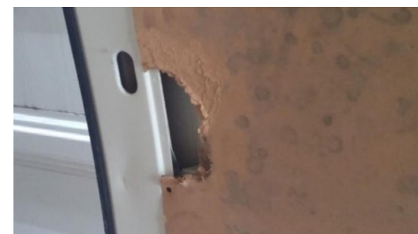
Protezioni interne in legno: Urti, pannello strappato, pannello mancante (esclusi i pannelli superiori delle porte)
